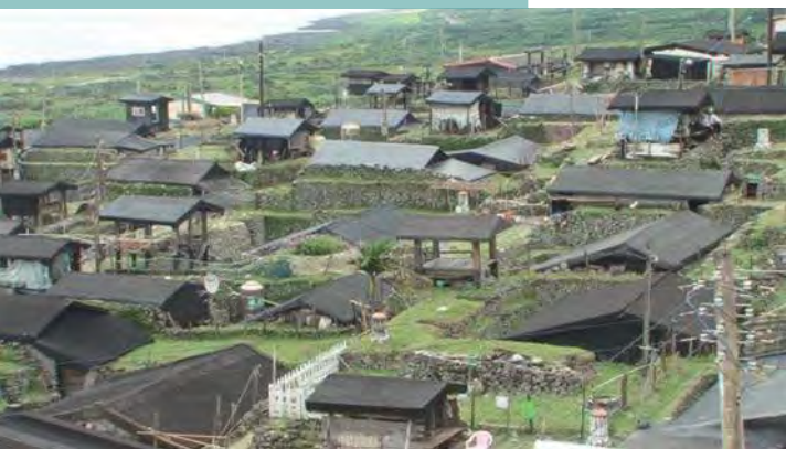
地下屋是蘭嶼達悟族的傳統建築。
