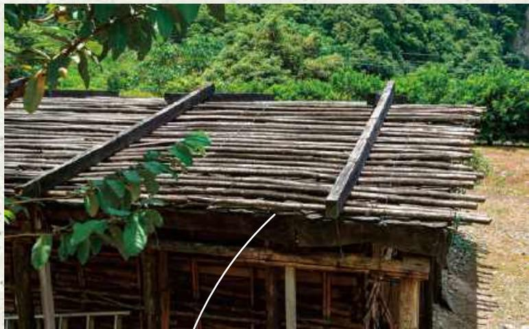
別以為屋頂似乎只是一片蓋上去，其實共有6層喔！必須先將竹子對剖後鋪平固定→鋪上防水用的檜木皮→將剖開的竹背以井字型放在檜木皮上→石板放在竹子肉面可以防滑→再鋪上一層竹子→最後蓋上木頭。這樣就百無一漏囉！
