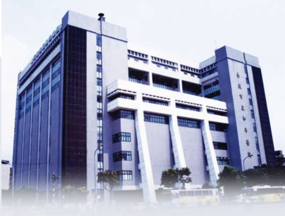
84年和平醫院A棟醫療大樓
