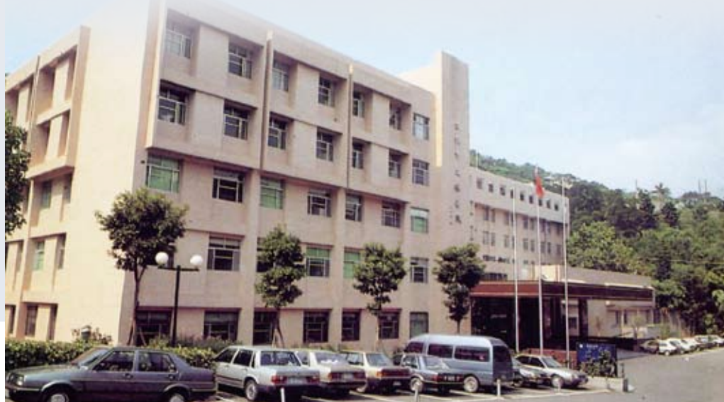
78年8月市立療養院第一院區B、C、D棟完工啓用
