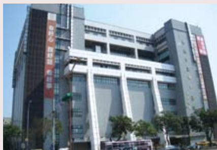
94年臺北市立聯合醫院和平院區A棟醫療大樓
