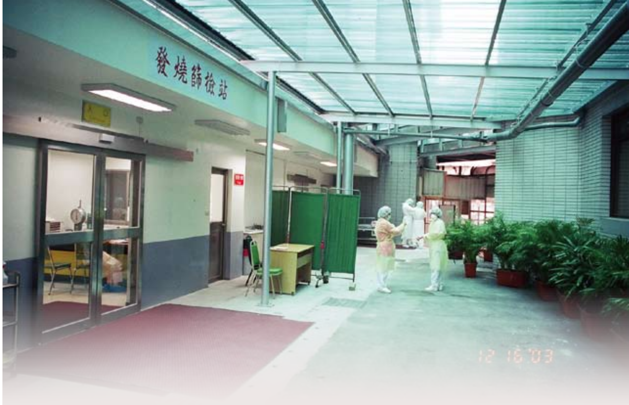
92年6月和平醫院發燒篩檢站完工
