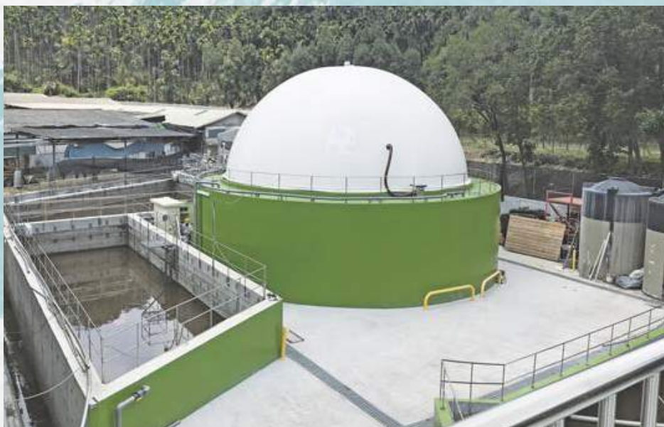
臺灣第一座二階段厭氧養豬場沼氣工廠。
